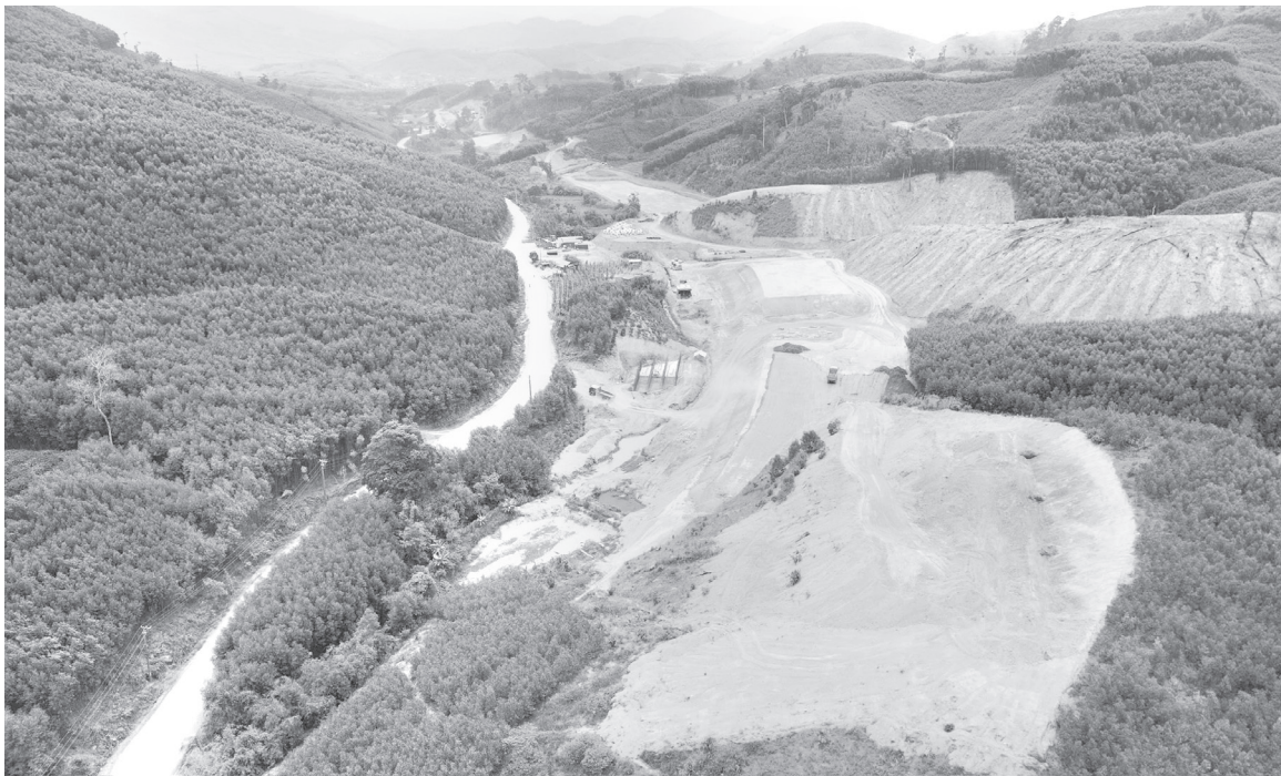
Dự án cao tốc Khánh Hòa - Buôn Ma Thuột qua tỉnh Đắk Lắk đang dần hình thành, bảo đảm đúng tiến độ đề ra. Ảnh: Cao Minh Giang
