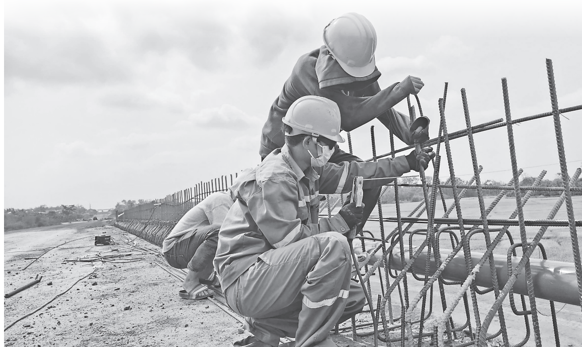
Công nhân thi công trên công trường cao tốc Khánh Hòa - Buôn Ma Thuột. Ảnh: H. Tuyết
