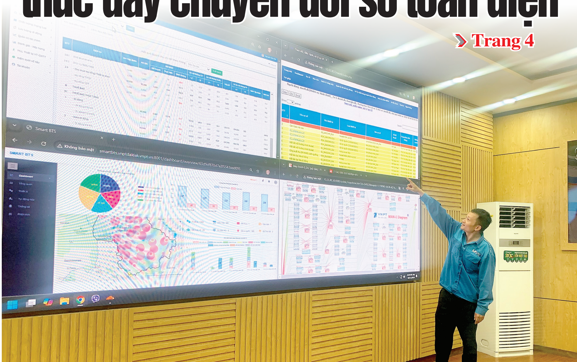
Trung tâm điều hành thông minh cung cấp các dịch vụ số hữu ích tại VNPT Đắk Lắk. Ảnh: Đỗ Lan
