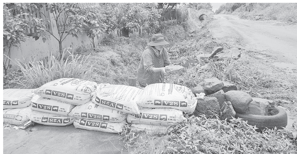
Người dân thôn Quỳnh Ngọc 1 phải dùng bao cát, đá xếp chồng lên nhau để hạn chế nước từ cửa xả thi công dang dở của dự án tràn vào nhà và vườn. Ảnh: A. Dũng
