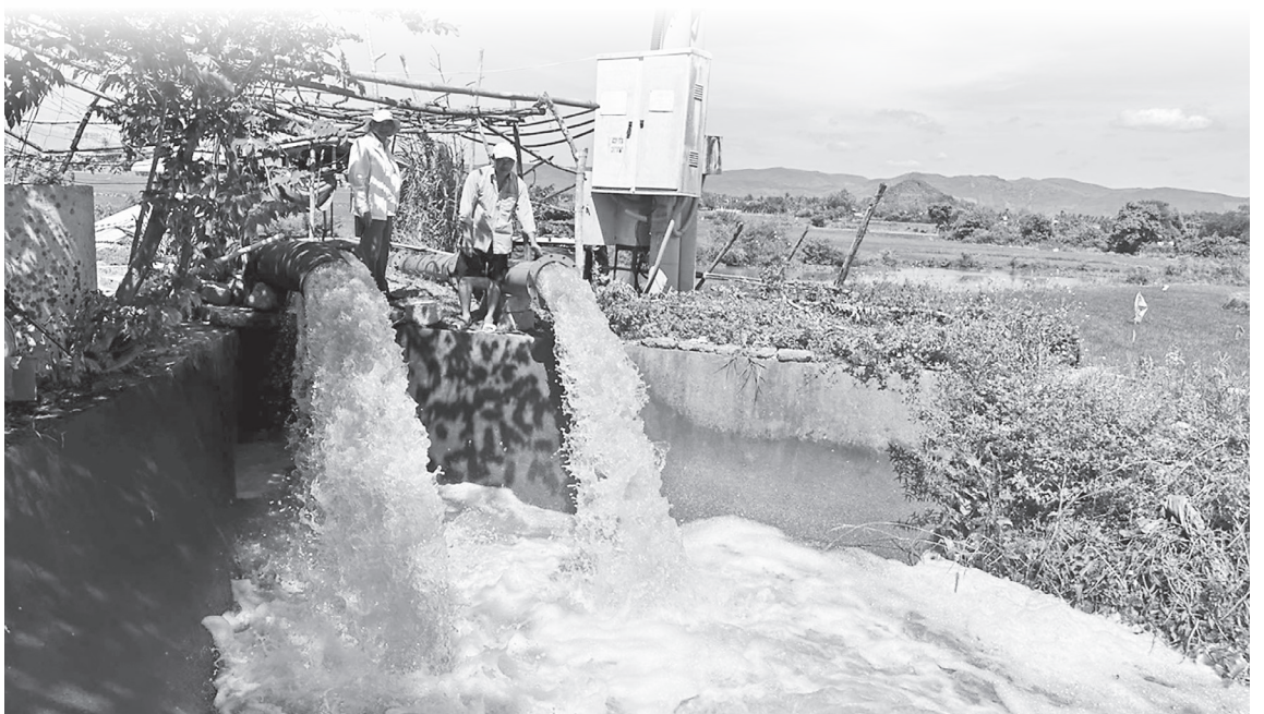
Vận hành trạm bơm Xi Phong - Bến Lội (xã Phú Hòa 2) để cung cấp nước tưới cho lúa vụ Hè Thu.. Ảnh: N. Hân
