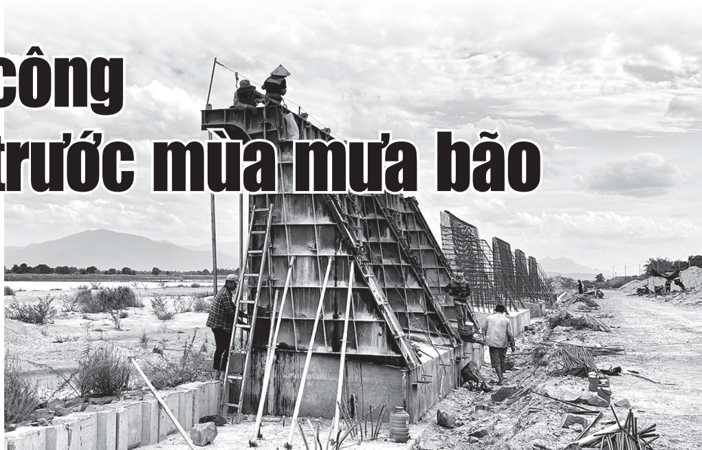
Đơn vị thi công tập trung hoàn thiện phần hạ bộ công trình kè chống sạt lở bờ tả sông Ba kết hợp phát triển hạ tầng đô thị đoạn qua thôn Vĩnh Phú. Ảnh: H.Như
