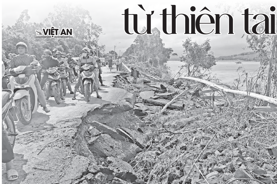
Mưa lũ gây sạt lở đường, ảnh hưởng đến quá trình lưu thông trên Quốc lộ 25 đoạn qua xã Phú Hòa 1.
