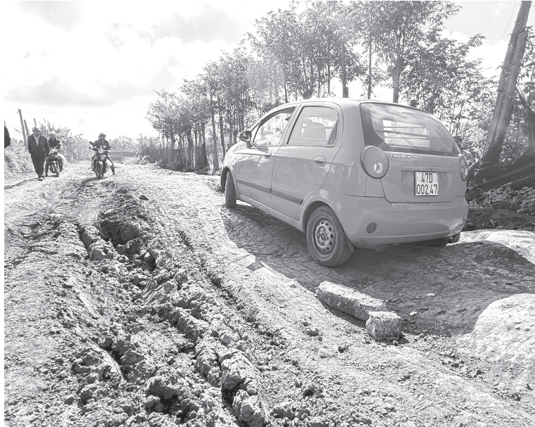
Tuyến đường Hồ Xuân Hương nổi dài xuống cấp trầm trọng, gây mất an toàn giao thông và ảnh hưởng đến đời sống, sinh kế của người dân phường Buôn Hồ. Ảnh: T. Xuân
