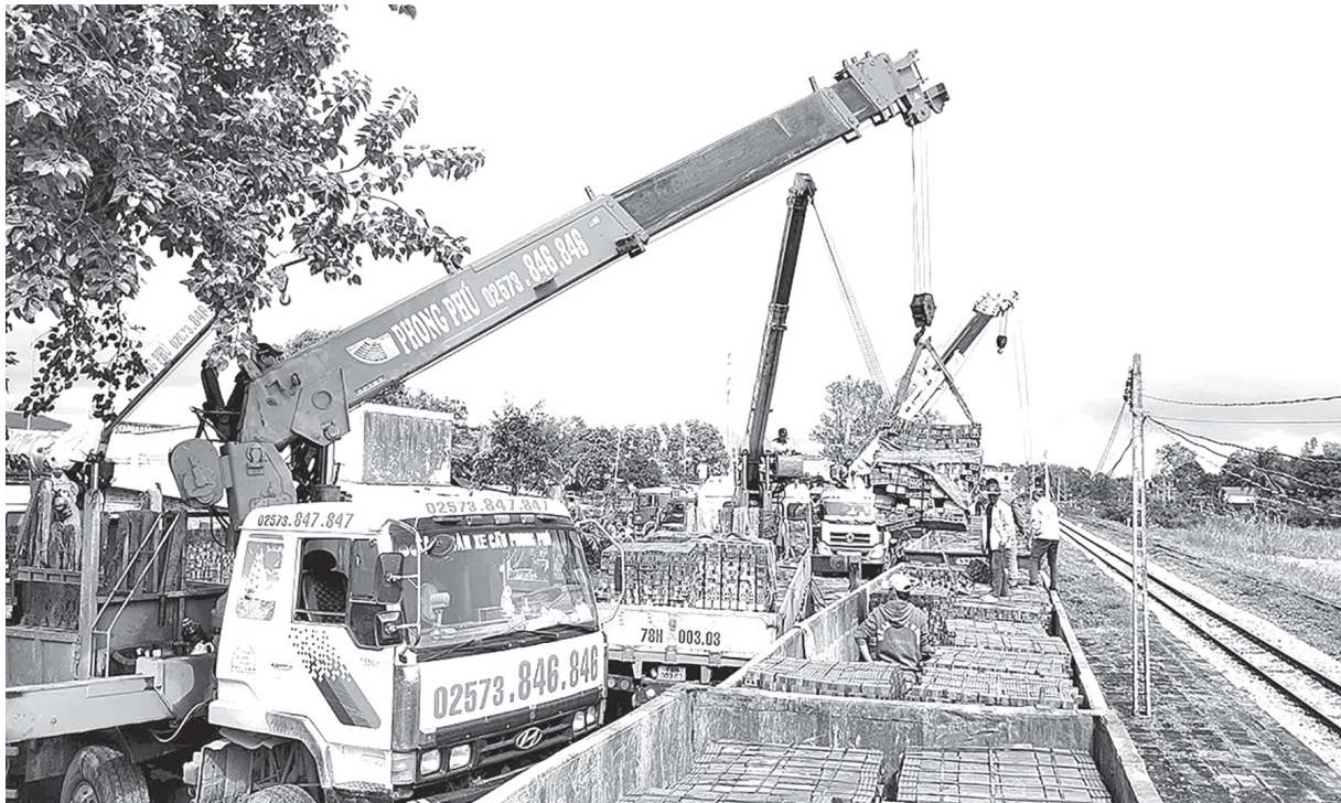
Bốc gạch do doanh nghiệp hỗ trợ để chuyển về các công trình xây nhà chống lũ cho người dân. Ảnh: Hồ Như
