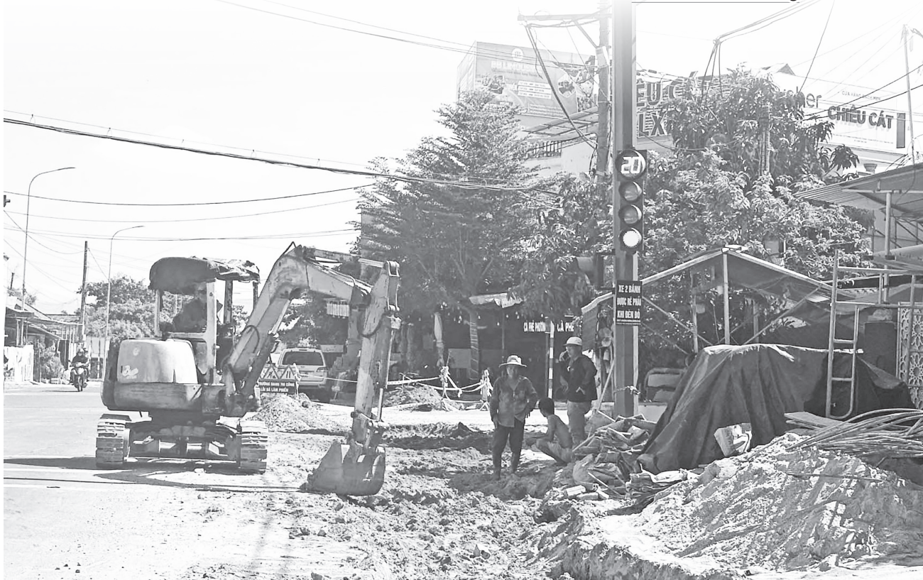
Thi công hệ thống thoát nước trên đường Nguyễn Tất Thành (đoạn qua phường Phú Yên). Ảnh: H. Như
