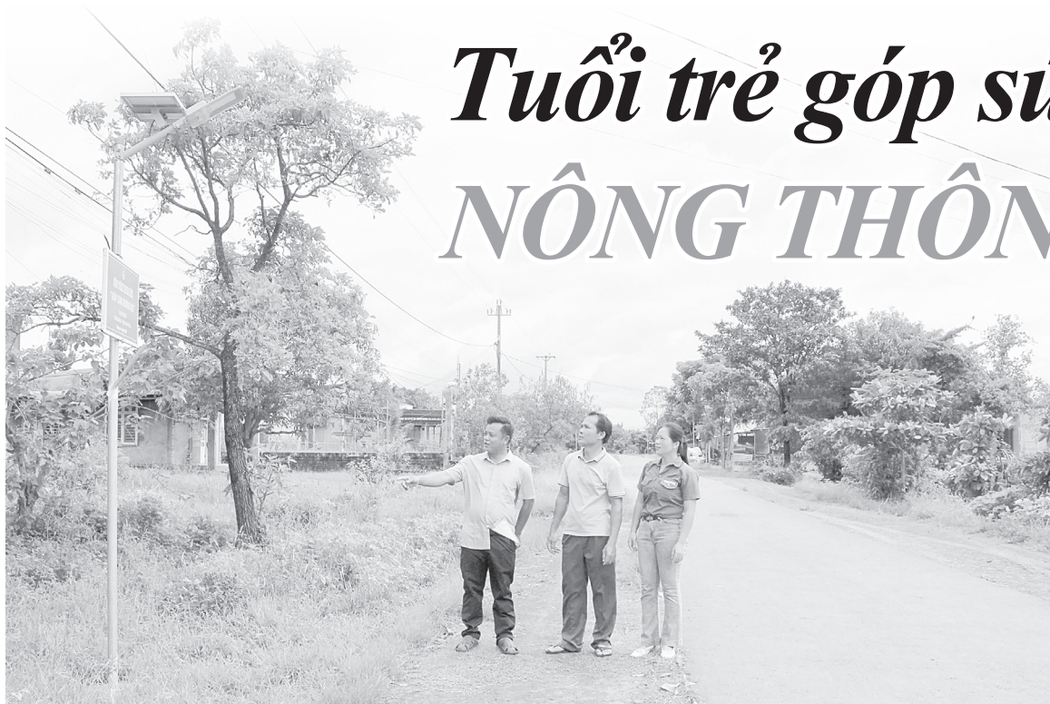
Hệ thống điện chiếu sáng đường dân sinh tại thôn 13, xã Ia Rvê giúp người dân thuận tiện hơn trong sinh hoạt, đi lại. Ảnh: V. Anh
