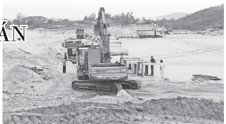
Dự án Tuyến đường bộ ven biển đang được các đơn vị, địa phương đẩy mạnh giải phóng mặt bằng, xây dựng các khu tái định cư. Ảnh: Tuyết Hương
