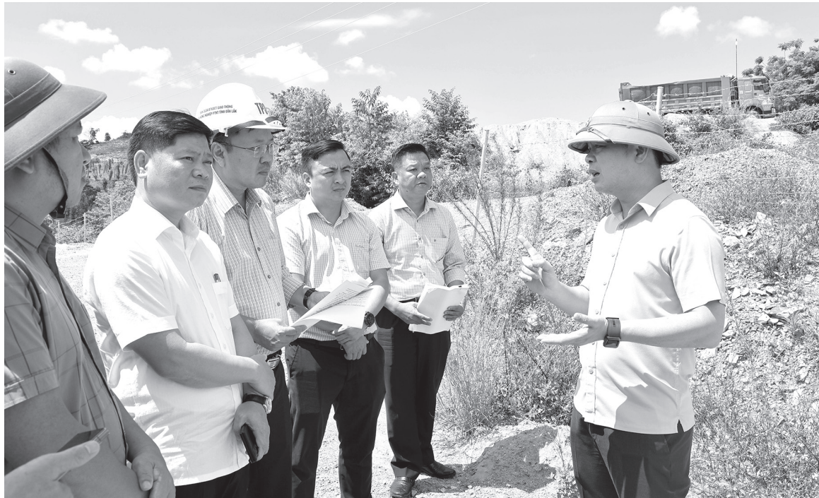
Chủ tịch UBND tỉnh Đỗ Hữu Huy kiểm tra thực địa Dự án thành phần 3 cao tốc Khánh Hòa - Buôn Ma Thuột. Ảnh: Hoàng Tuyết
