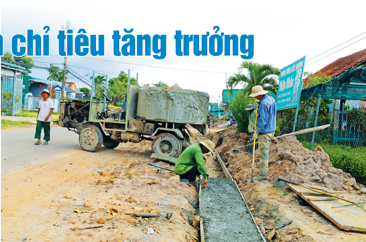
Một số tuyến đường giao thông trên địa bàn xã Ea Păl được đầu tư, nâng cấp nhằm tạo thuận lợi cho người dân đi lại. Ảnh: T. Xuân
