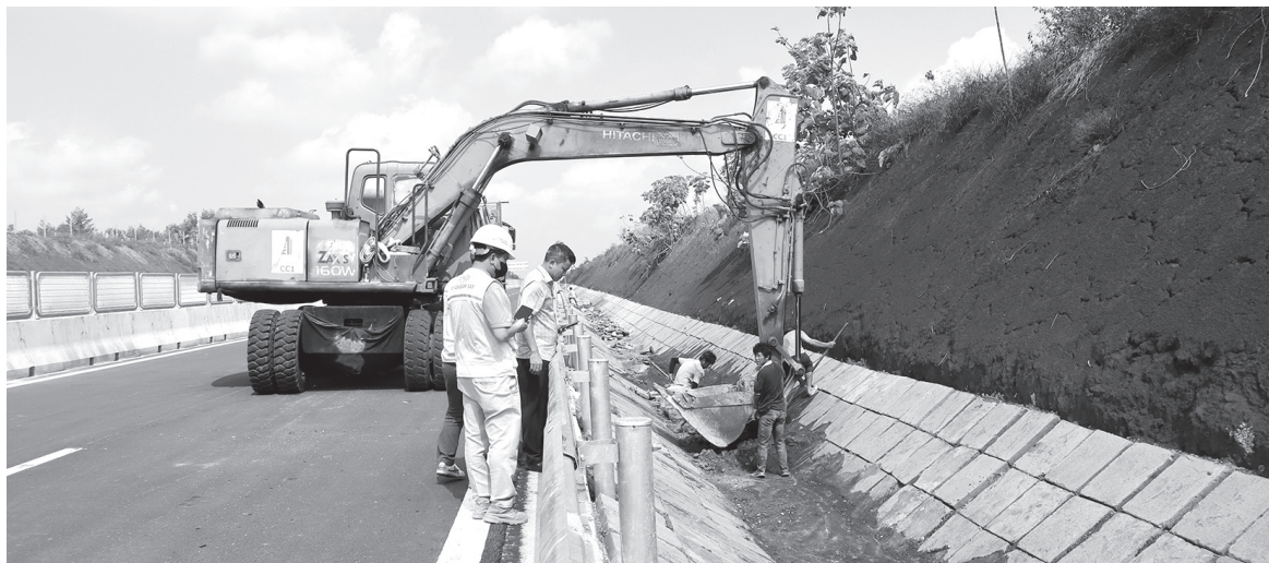
Thi công những hạng mục cuối cùng của Dự án thành phần 3 cao tốc Khánh Hòa - Buôn Ma Thuột. Ảnh: Hoàng Tuyết
