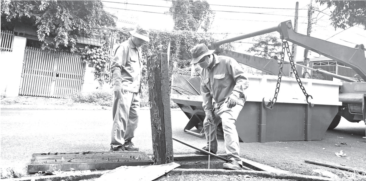
Công nhân Công ty Cổ phần Đô thị và Môi trường Đắk Lắk vệ sinh cống thoát nước. Ảnh: K. Lê
