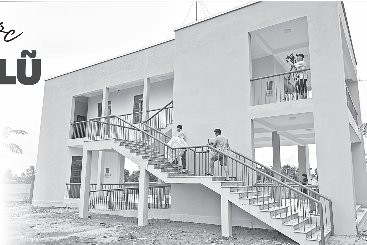
Nhà sinh hoạt cộng đồng kết hợp phòng tránh lũ đã được hoàn thiện tại phường Tuy Hòa. Ảnh: M. Hà
