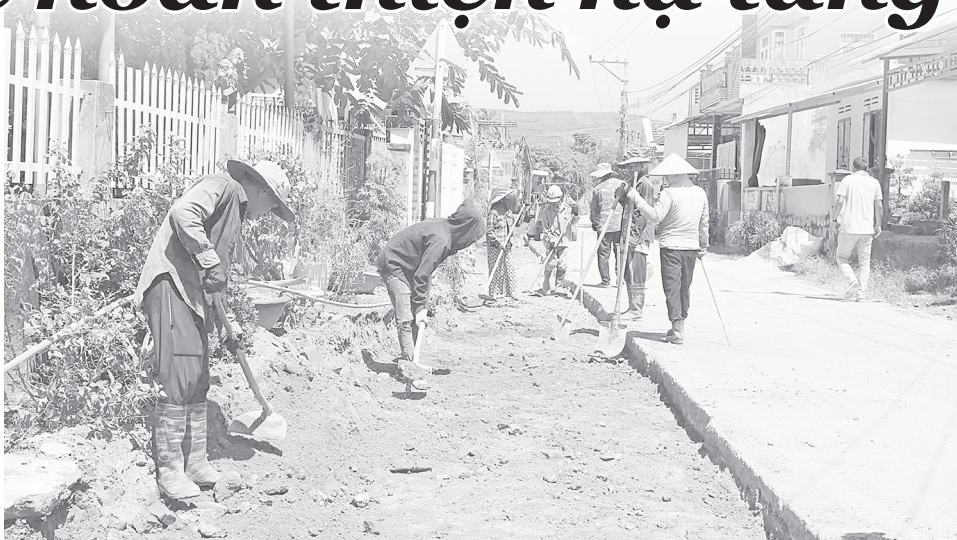
Thi công mở rộng đường bê tông tại thôn Bình Hòa, xã Tuy An Bắc. Ảnh: N. Thanh
