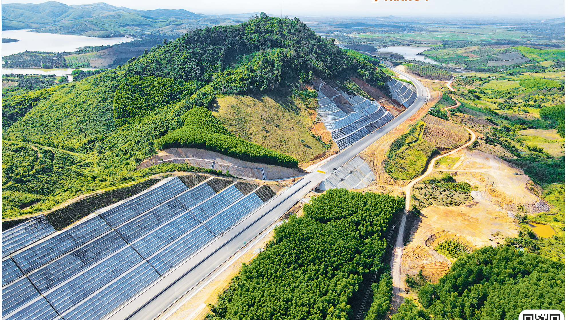
Cao tốc Khánh Hòa - Buon Ma Thuột đang được khẩn trương thi công, góp phần đẩy nhanh tiến độ giải ngân. Ảnh: Minh Chi
