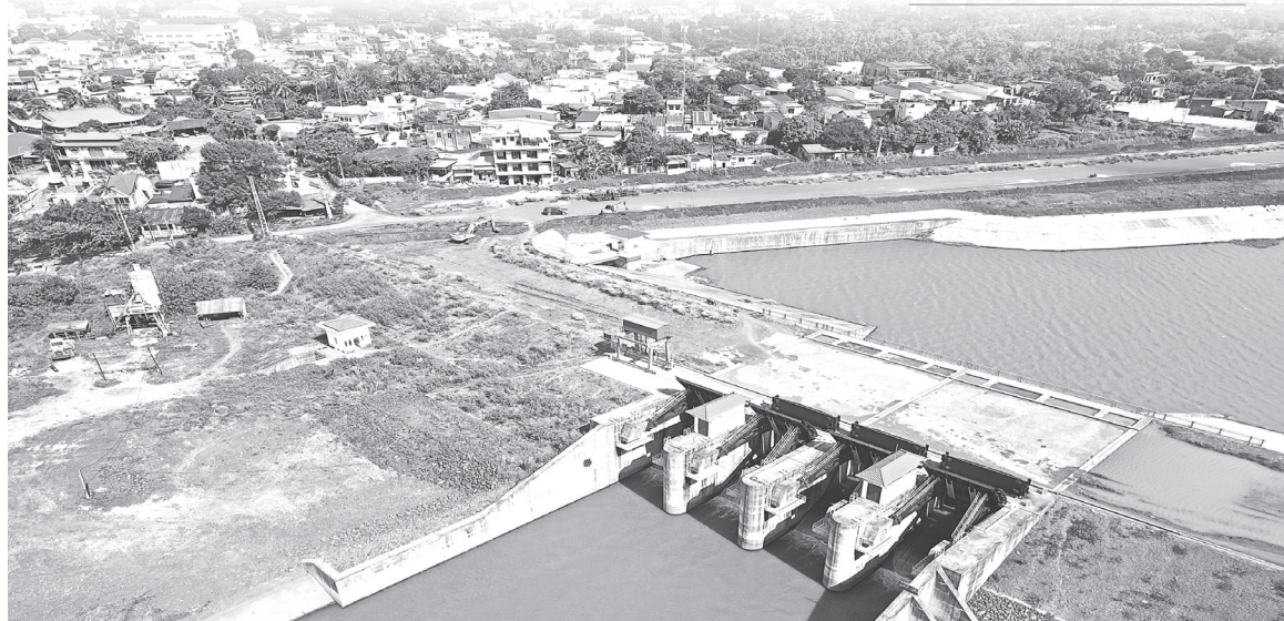
Dự án Hồ thủy lợi Ea Tam đang được đẩy nhanh tiến độ thực hiện. Ảnh: Minh Chi
