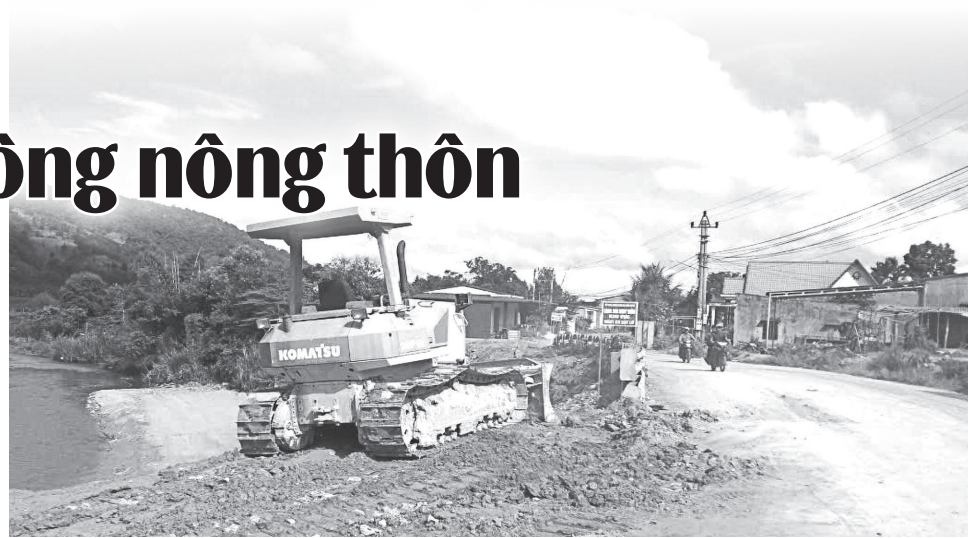
Thi công Dự án khắc phục kè chống sạt lở và nắn dòng suối tại buôn Liêng Keh (xã Đắk Phơi). Ảnh: H. Tuyết
