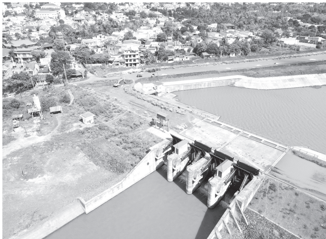
Dự án Hồ thủy lợi Ea Tam (phường Buôn Ma Thuột) đang được đẩy nhanh tiến độ thi công. Ảnh: Minh Chi
